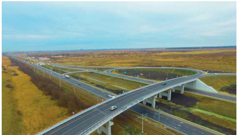
Транспортная развязка на автомобильной дороге Энем – Новобогояй
