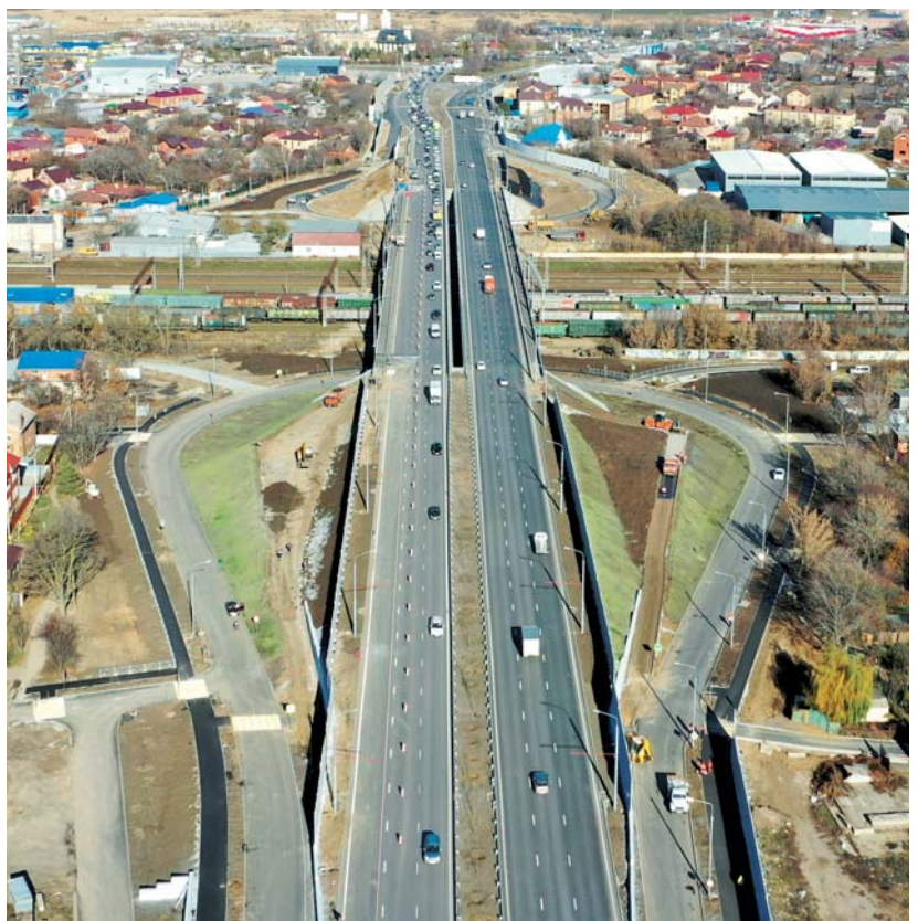
Путепровод по ул. Малиновского
