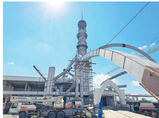
Строительство ж/д вокзала Грозный
