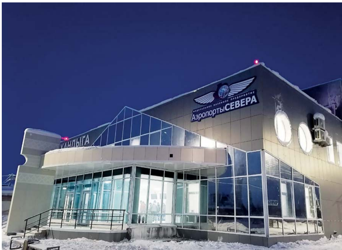
Новое служебно-пассажирское здание аэропорт Хандыга (Якутия)
