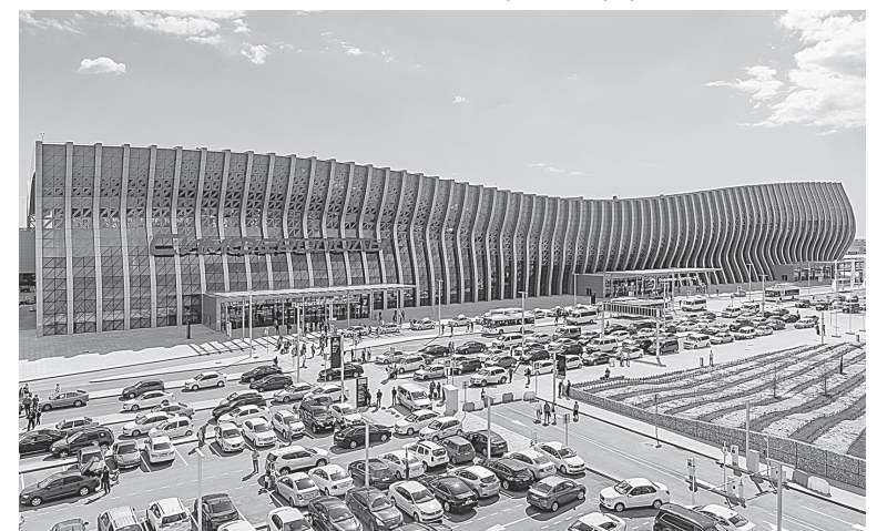
Аэровокзальный комплекс «Симферополь» введен в строй весной нынешнего года
